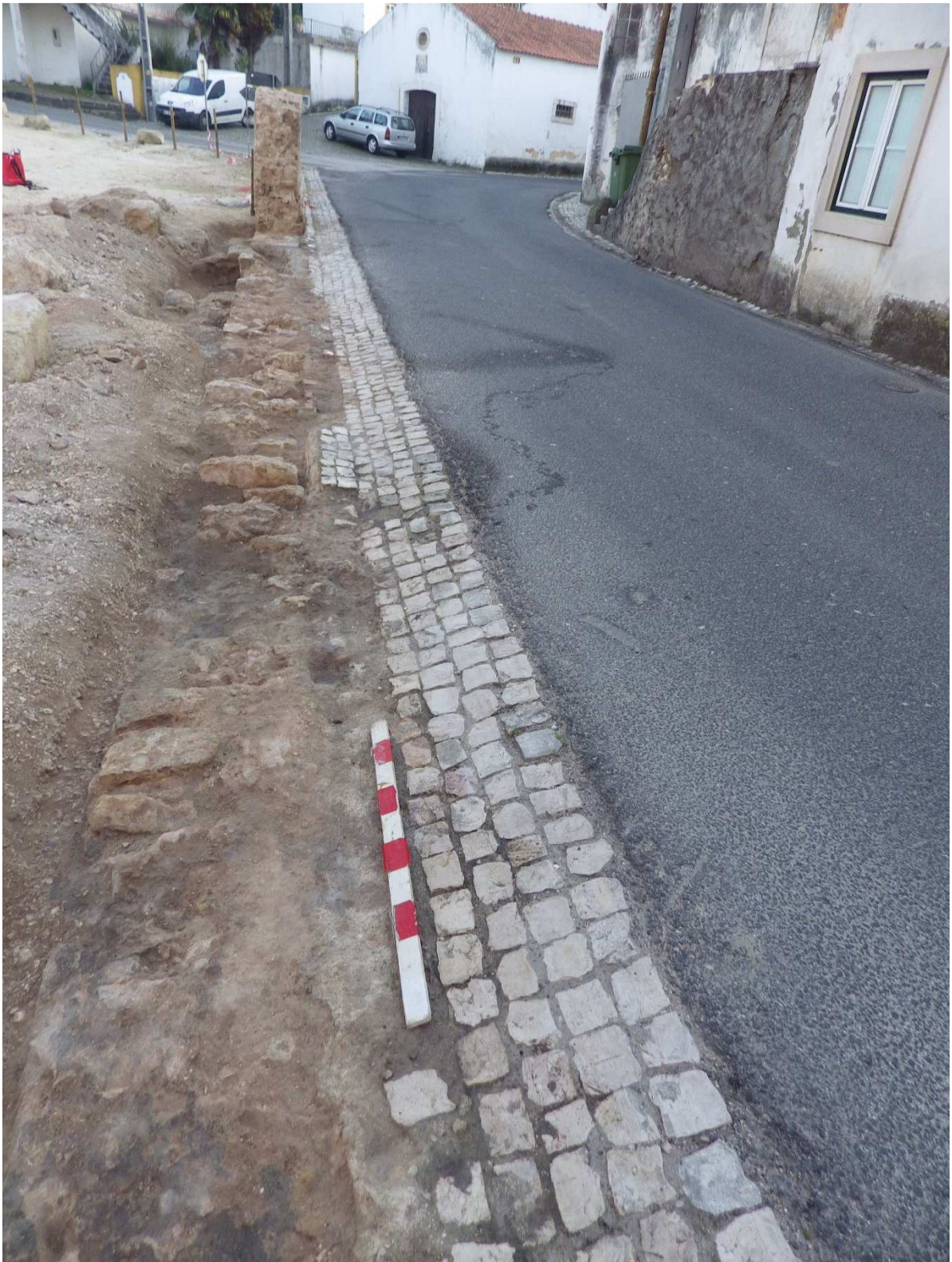
Figura 4. Mosteiro de Coz, vista geral, a partir de norte, da fundação da antiga cerca em confrontação com a rua de Santa Rita. Fonte: António Figueiredo, 2015.
