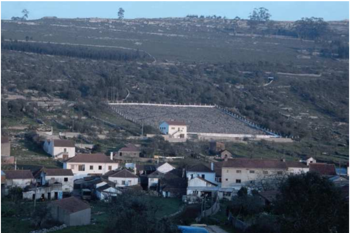
Figura 1. Cisterna coletiva, Serro Ventoso Fonte: Nuno Carvalho
