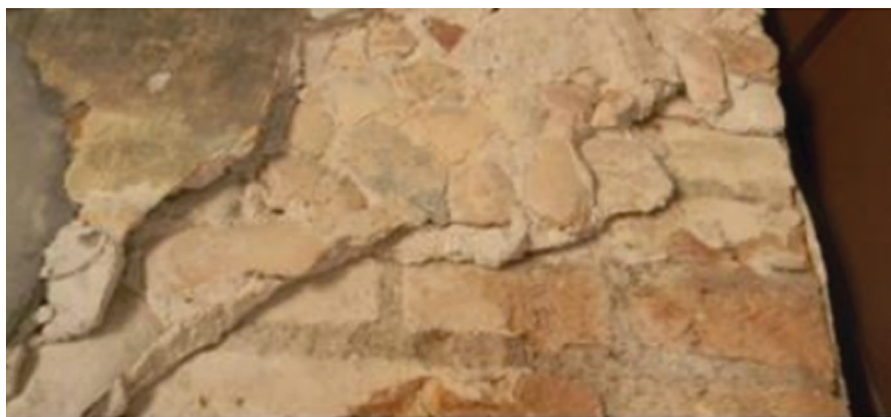
Figura 5. Detalhe do reboco da Casa de Câmara e Cadeia de Brejo da Madre de Deus em Pernambuco, 2011.
