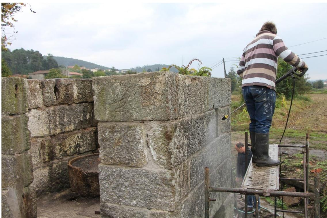
Figura 6 – Trabalhos de limpeza com jato de água no exterior e interior da estrutura de moagem. Fonte: Autores
