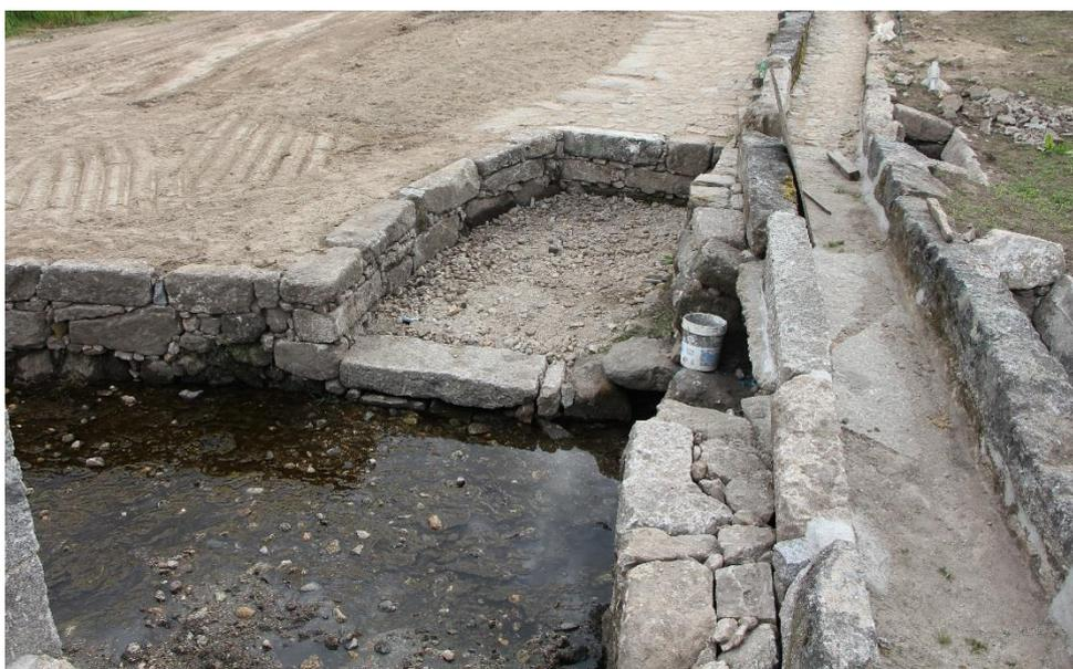
Figura 14 – Aspeto final dos trabalhos de construção dos muros de delimitação da presa. Fonte: Autores
