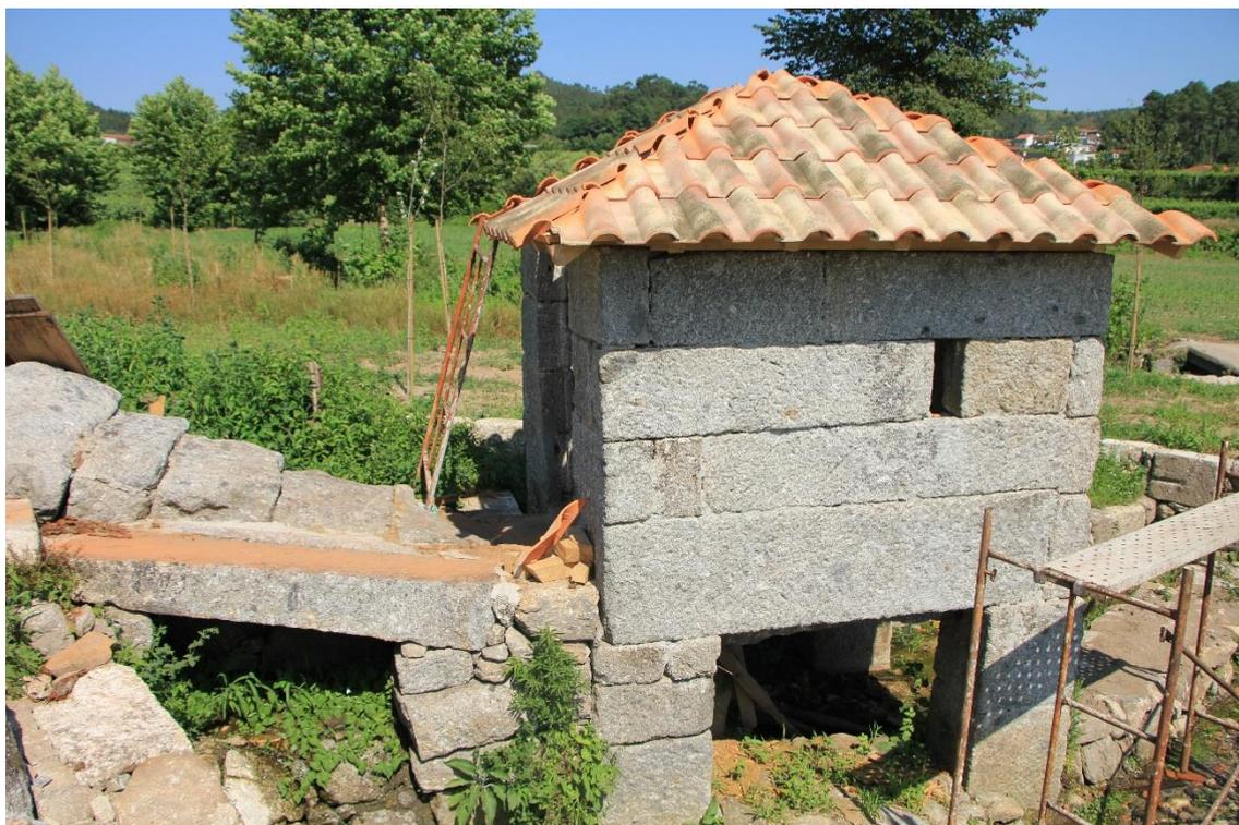
Figura 17 – Vista nordeste do processo de montagem da nova cobertura do moinho. Fonte: Autores
