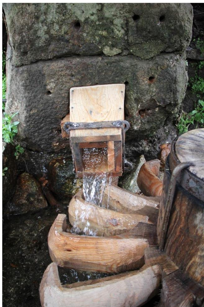
Figura 27 – Pormenor da nova *seteira* colocada no *cubo*. Fonte: Autores
