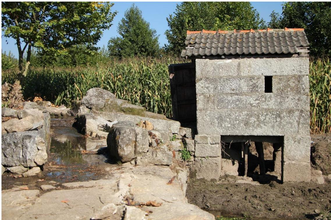
Figura 3 – Alçado sudoeste do Moinho do Ribeiro com destaque para o *cubo* que funciona como plataforma de acesso entre a *levada* e o moinho. Fonte: Autores
