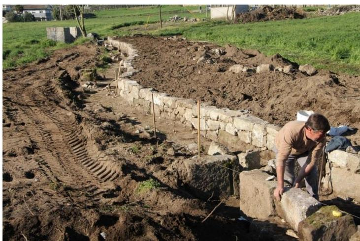
Figura 10 – Trabalhos de reconstrução dos muros da *levada* do Moinho do Ribeiro. Fonte: Autores
