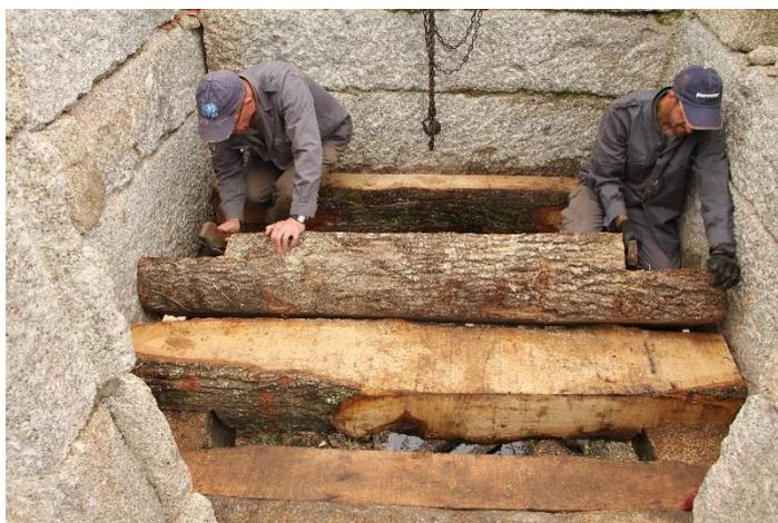
Figura 18 – Trabalhos de colocação das novas traves de madeira para assentamento do piso de moagem. Fonte: Autores
