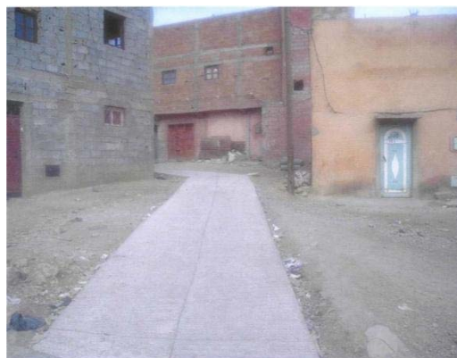
Photo d'une partie de douar « Boulaghraib » après l'opération de restructuration. (Voir le chemin piéton réalisé sur le réseau d'assainissement, les branchements, individuel de l'eau potable et de l'électricité.
