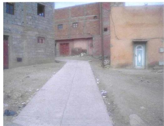
Photo d'une partie de douar « Boulghraib » après l'opération de restructuration. (Voir le chemin piéton réalisé sur le réseau d'assainissement, les branchements, individuel de l'eau potable et de l'électricité.
