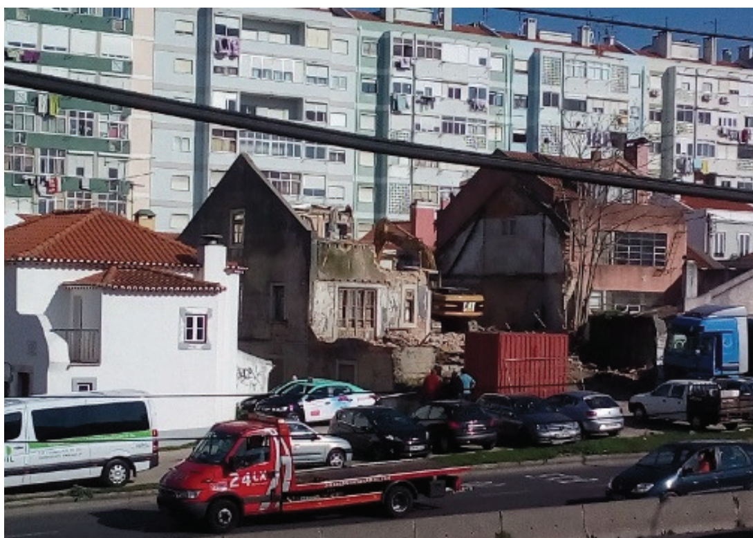
Figura 28. Aspecto da mais recente “vítima do tempo” na Rua do Lumiar. Nesta casa muito há para reconstruir e pouco para reabilitar. Reveja-se como era esta casa na Figura 26. Fonte: fotografia privada, 13 de Fevereiro de 2019.
