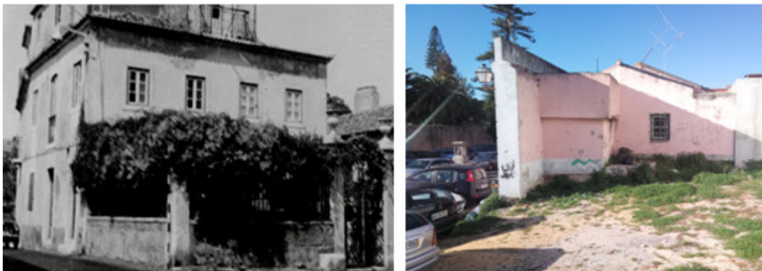
Figura 14. Fachada da casa das Belas , cujo tardo dava para o palácio e enquadrava o Largo da Duquesa e imagem actual do espaço depois de esta casa ter sido demolida. Fontes: http://www.cph.ipt.pt/download/OIPDownload/vade_mecum/Vademecum_AC_1.pdf e fotografia privada de 25 de Janeiro 2019
