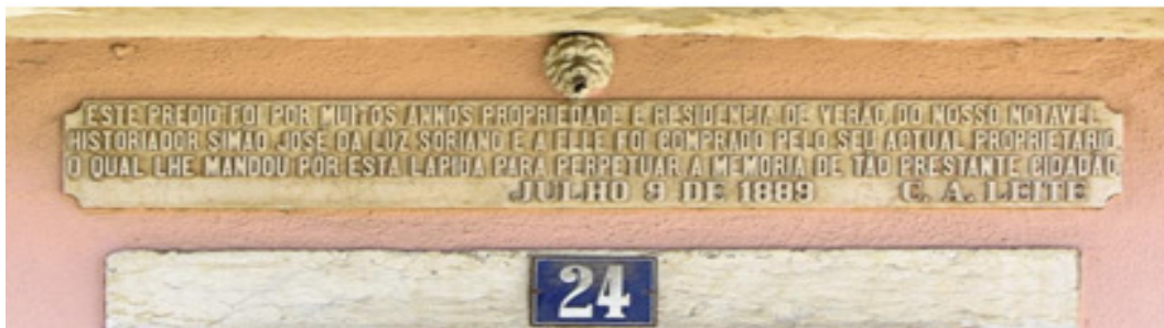
Figura 7. Lápide na fachada da Casa Luz Soriano: “Este prédio foi muitos anos propriedade e residencia de Verão do nosso notável historiador Simão José da Luz Soriano e a elle foi comprado pelo seu actual proprietário o qual lhe mandou por esta lápida para perpetuar a memoria de tão prestante cidadão”. Julho 9 de 1889 C. A. Leite. Fonte: http://www.cph.ipt.pt/download/OIPDownload/vade_mecum/Vademecum_AC_1.pdf
