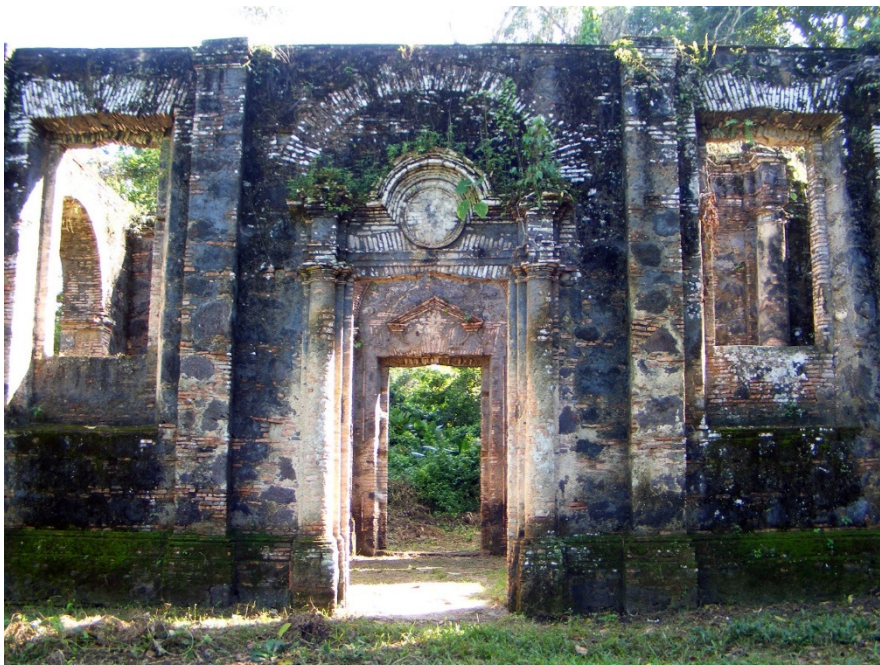
Figura 11. Estado atual do processo de arruinamento no Engenho do Murutucu. Fonte: Costa, 2014.
