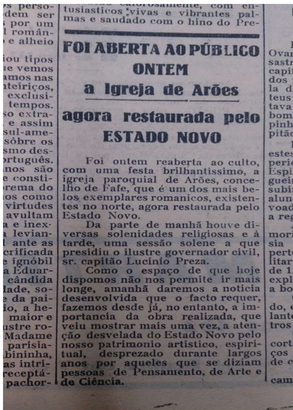
Figura 5. Abertura da igreja de Arões em Fafe após as obras de restauro. Fonte: Ano IX, 1935, 16 de agosto, sexta-feira, nº 2787, p. 1 (capa).
