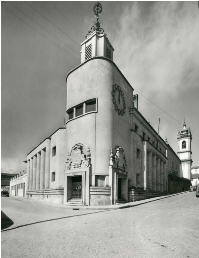
Figura 1. Edifício Caixa Geral de Depósitos/ Filial da Guarda inaugurada em 1942. Fonte: Arquivo Fotográfico, Caixa Geral de Depósitos.
