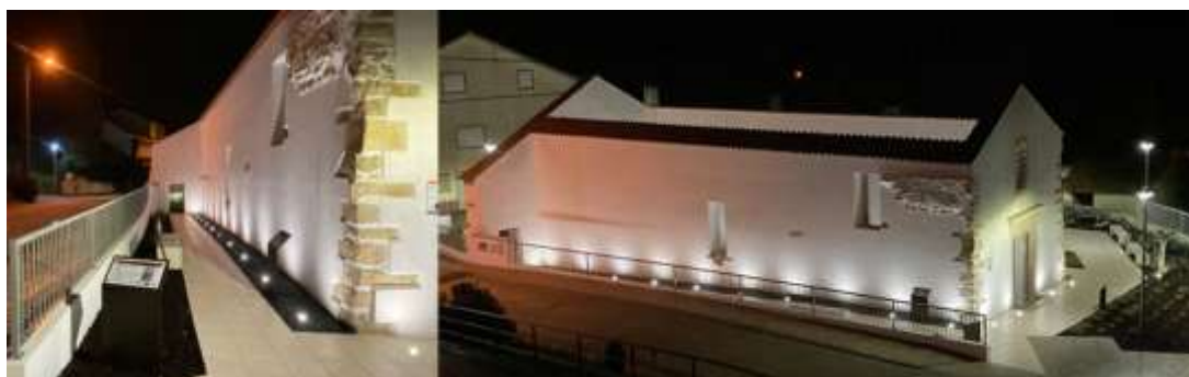
Fig. 11 - Utilização de recursos solares para garantir a iluminação noturna do monumento e dos painéis informativos. (Fonte: arquivo do autor)
