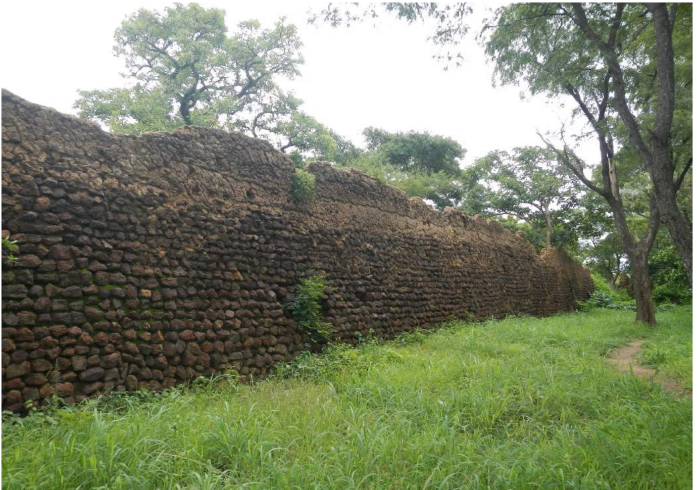
Figure 2: Vue partielle de la face interne du mur d'enceinte nord des ruines de Loropéni.
