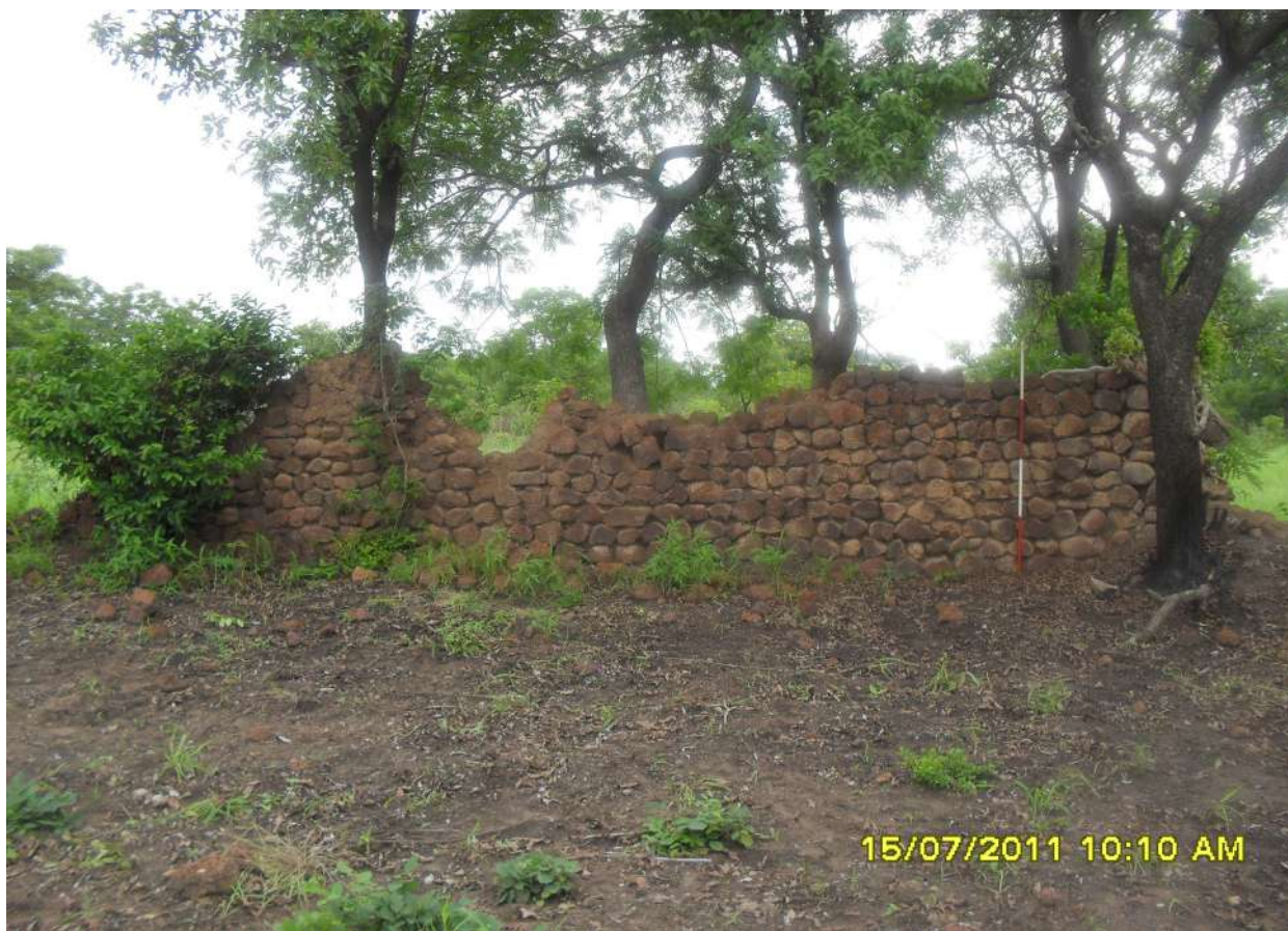
Figure 3: Vue partielle de la façade nord de l'enceinte de Kongonyo à Obiré.
