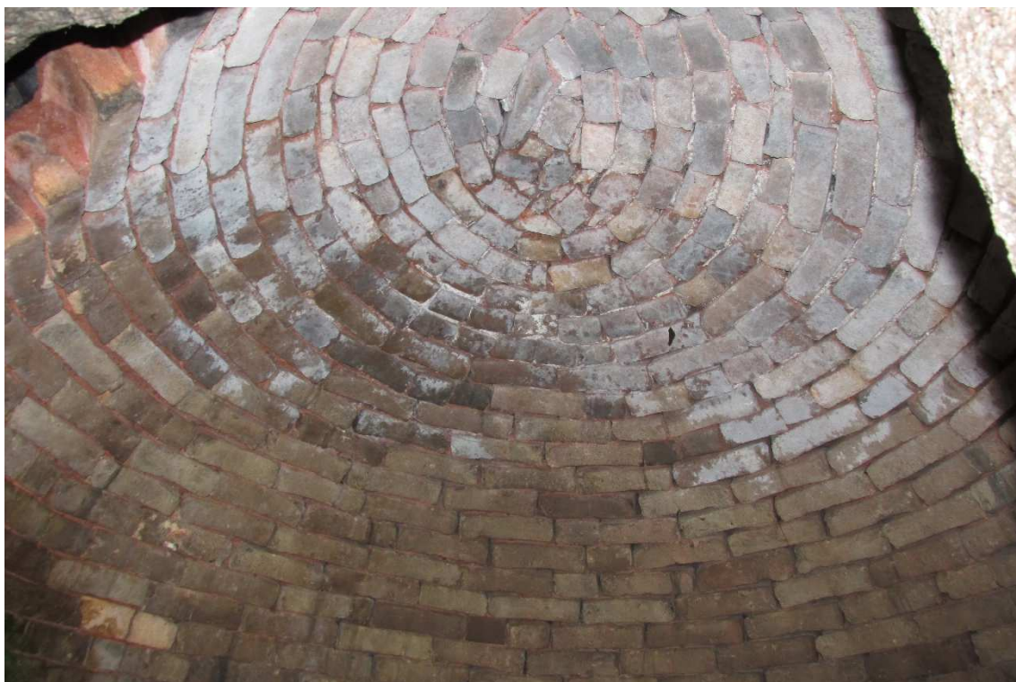
Figura 7. Interior da fornalha do forno nº2 do lugar de Seara (branda). Cúpula. 2015. Fonte: Diana Carvalho.
