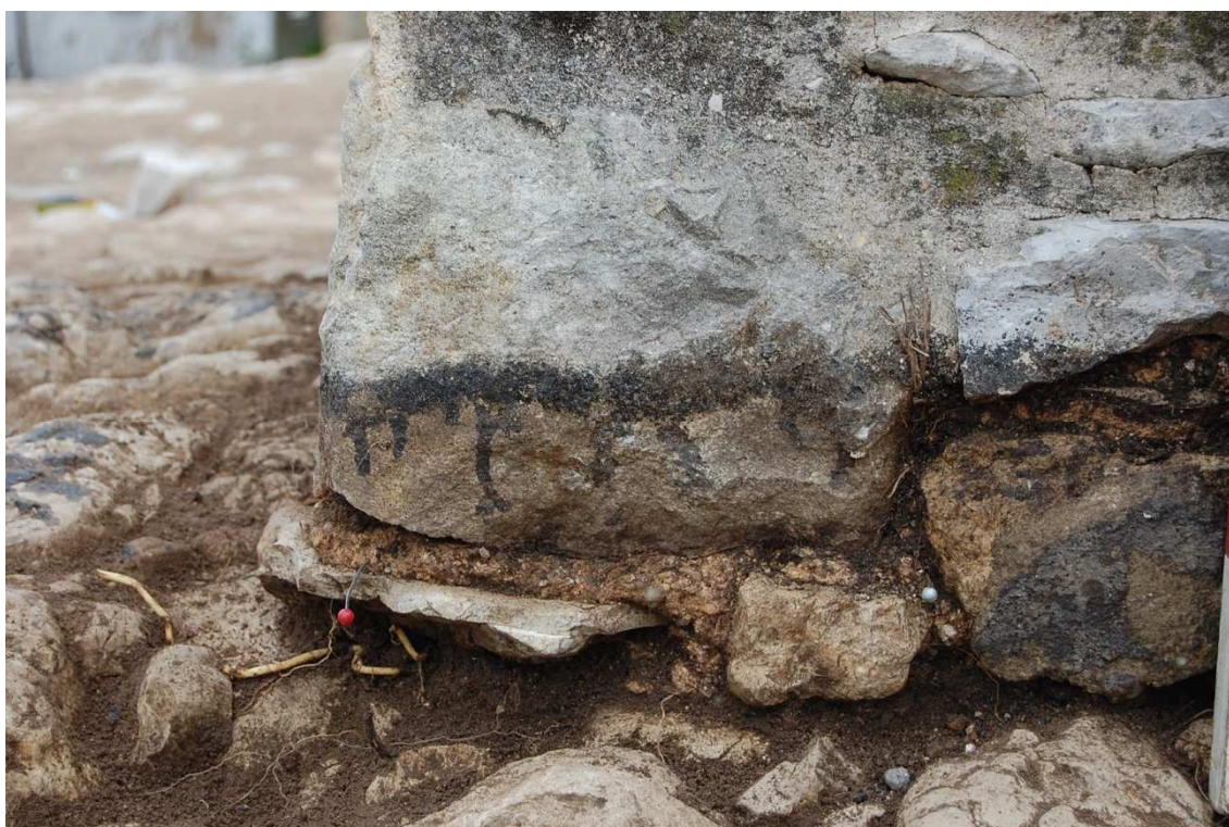
Figura 40. Vestígios de Argamassa de cal aérea, na base do perfil do Cruzeiro no lado Norte. Fonte: Ana Cruz, 2016.
