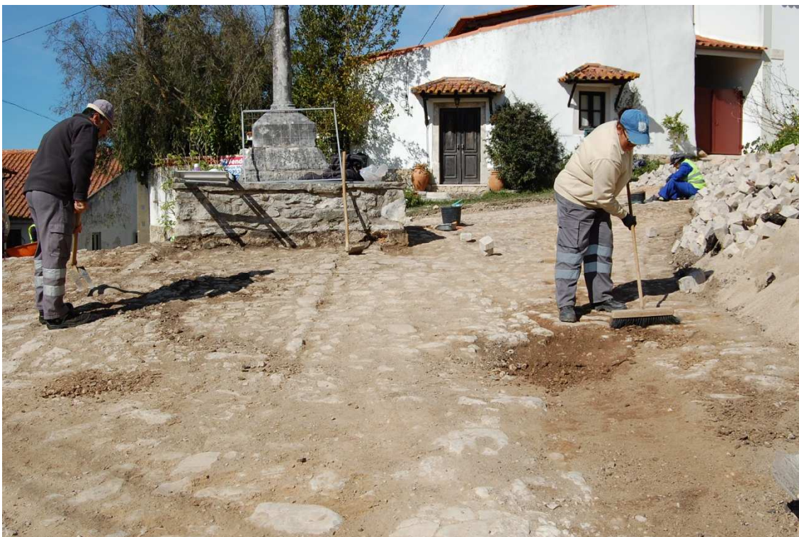
Figura 14. Limpeza geral da zona Norte da Encruzilhada onde é possível observar as margens e o enchimento da Calçada. Fonte: Ana Cruz, 2016
