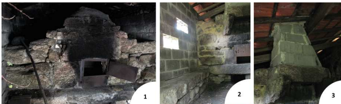
Figura 12. Interiores dos fornos da Figura 11. 1 – interior do forno nº2 de Alagoa (inverneira). 2 – interior do forno de Podre (inverneira). 3 - pormenor da chaminé do forno de Podre (inverneira). 2015. Fonte: Diana Carvalho.
