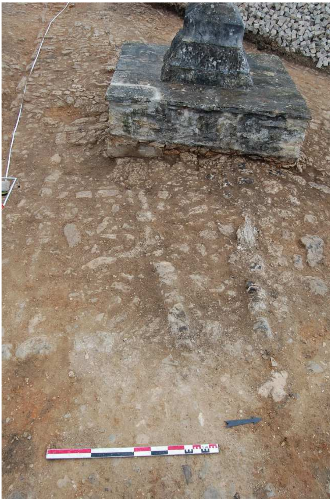
Figura 26. Lado Oeste da Encruzilhada; são visíveis margens não paralelas, enchimento desproporcionado e travões pouco cuidados. Fonte: Ana Cruz, 2016
