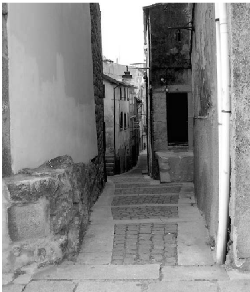
Figura 16. Aspecto da Muralha e de troço de calçada medieval na Rua da Violinha, em Braga. Fonte: Ribeiro, 2008: 386.
