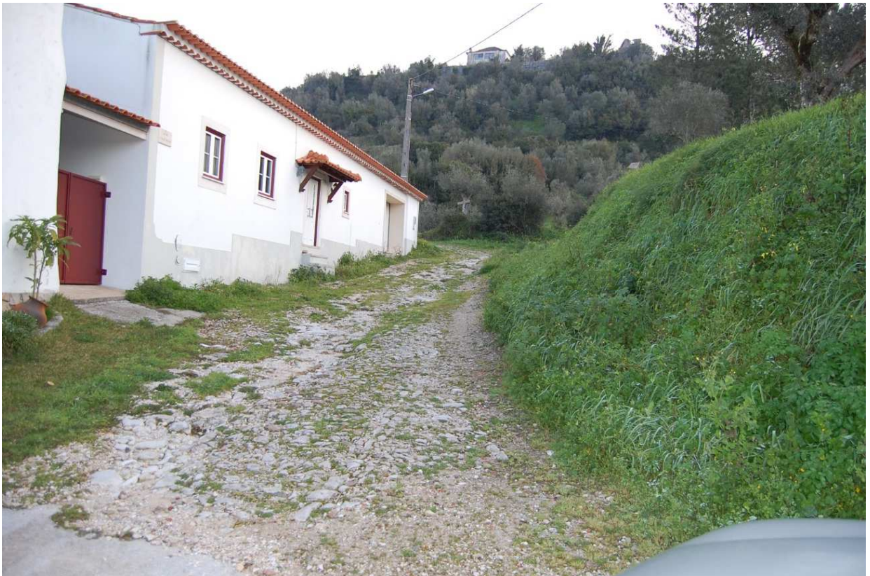
Figura 10. Vista do troço de Calçada de Nº Srª da Conceição. Fonte: Ana Cruz, 2016
