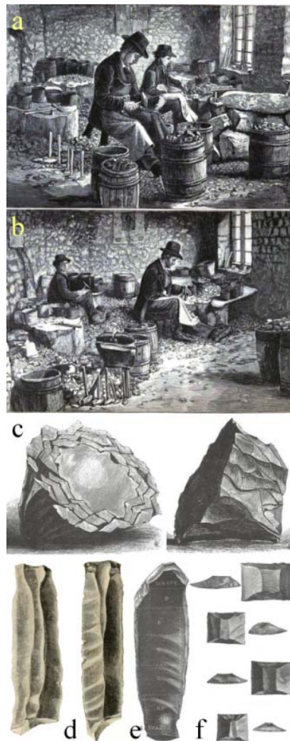
Figura 1– Imágenes históricas de talladores de piedras para chispeo registradas en la segunda mitad del siglo XIX. a-b) maestro y aprendiz trabajando en el taller, c) núcleo de hojas y lascas laminares obtenidas por percusión directa, d-e) extracciones laminares y esquema de fragmentación, f) productos finales para ser utilizados en fusiles y pistolas. Fuente: tomado y modificado de Skertchly, 1879.
