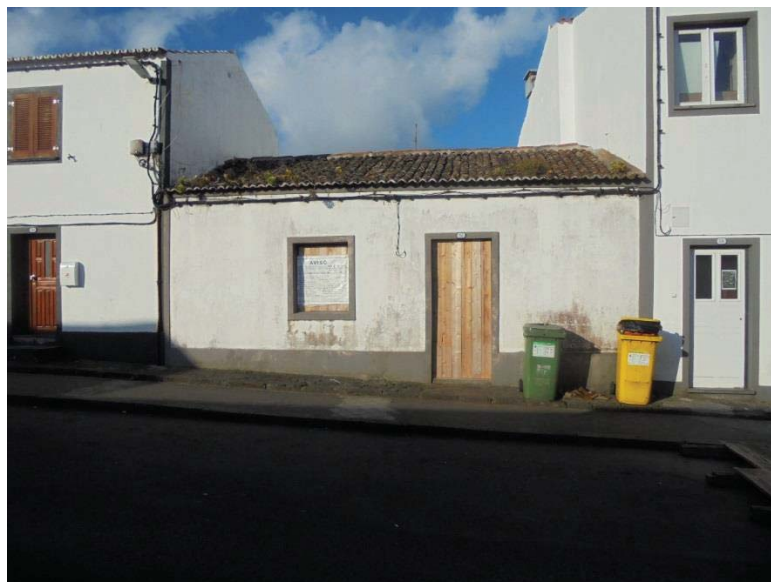
Figura 1 – Fachada do imóvel. Fonte: Luís Borges
