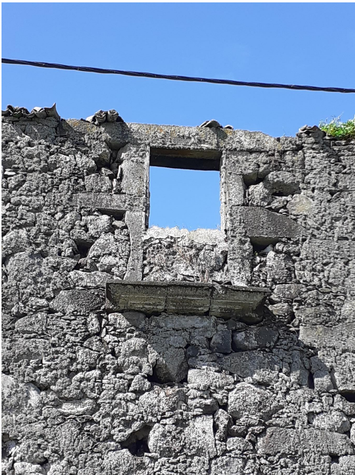
Figura 11 – Pormenor da janela superior e base da varanda. Fonte: Luis Borges
