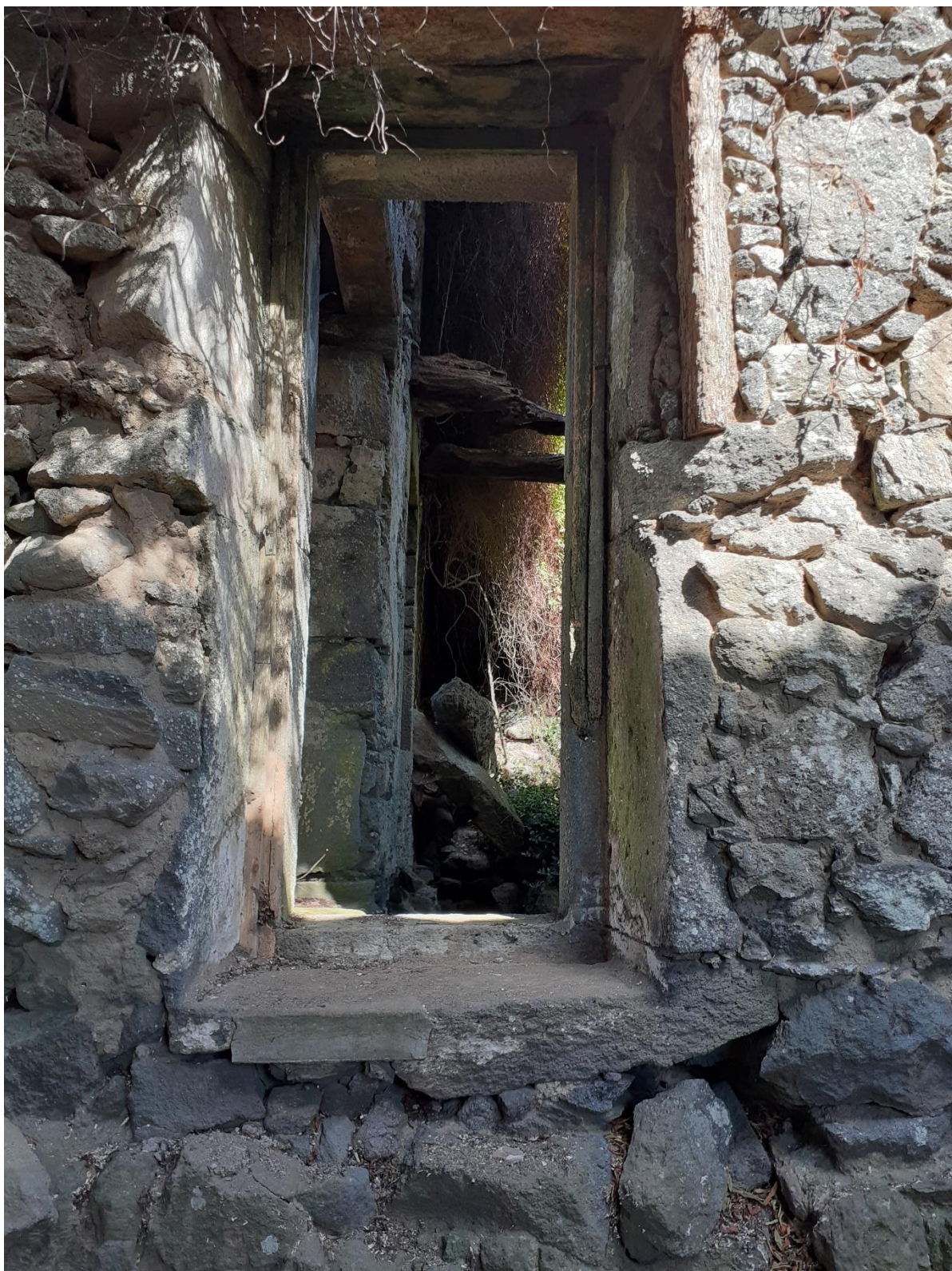
Figura 15 – Pormenor dos vãos de porta do piso 2. Fonte: Luís Borges
