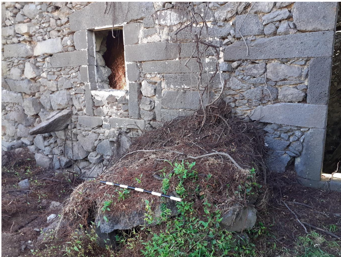
Figura 12 – Pormenor do pocilgo e do escoamento de resíduos para o pocilgo. Fonte: Luis Borges
