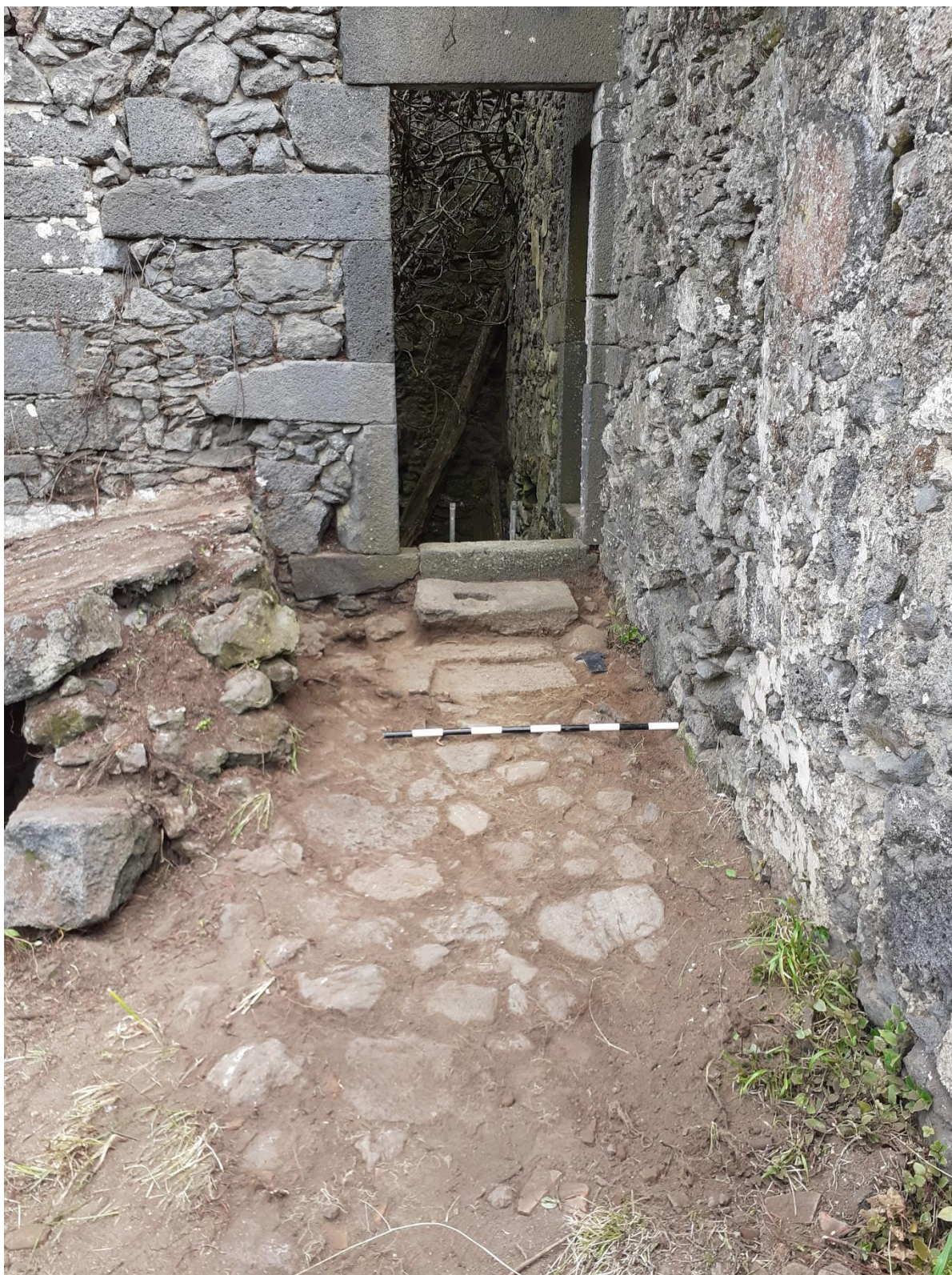
Figura 21 – Sondagem 3 - pavimento. Fonte: Luis Borges
