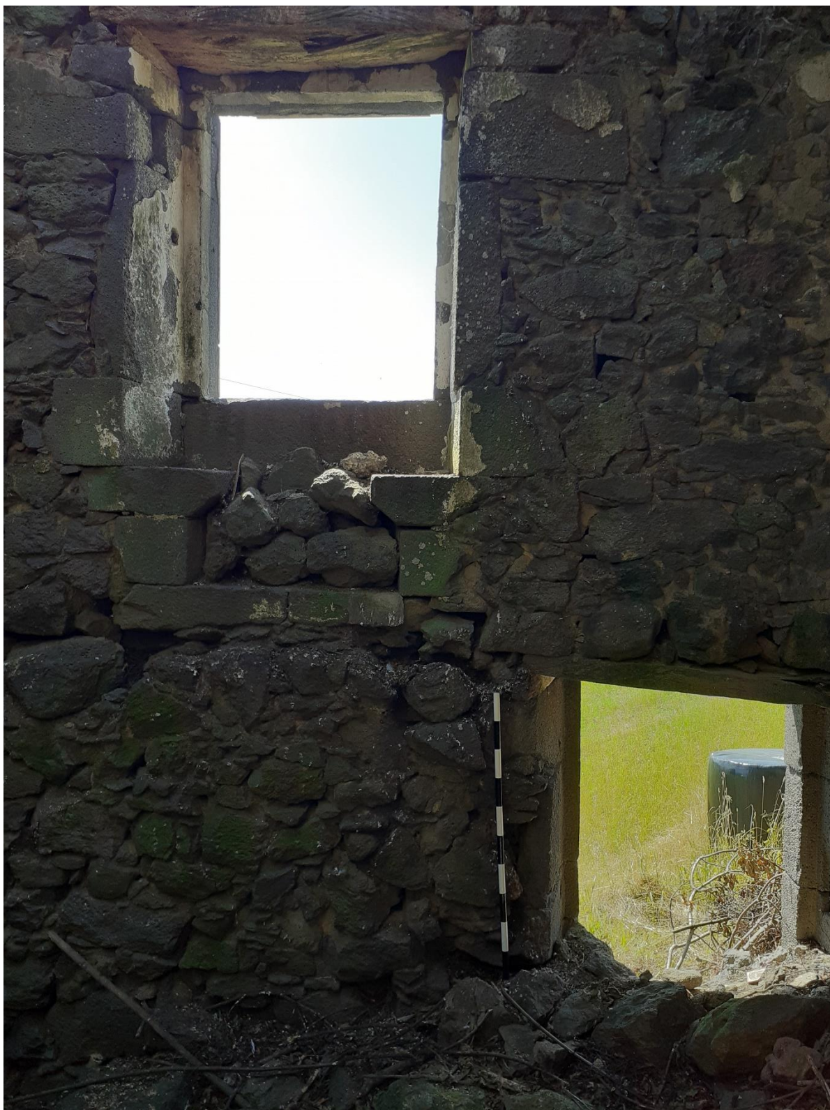
Figura 13 – Pormenor das conversadeiras da janela nascente do piso 2. Fonte: Luis Borges
