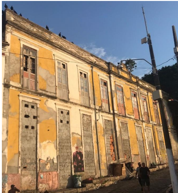
Figura 3. Sobrado n.16, localizado na Ladeira do Castelo. Fonte: Autora, 2021.
