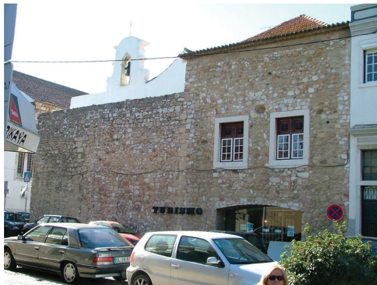
Figura 2. Vista exterior do imóvel a partir do Largo do Quebedo. Fonte: Intervenção Arqueológica na Casa do Corpo Santo. Setúbal, 2008.
