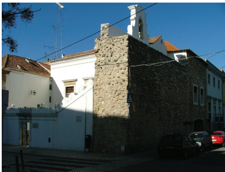
Figura 3. Vista exterior do imóvel a partir da Rua de Santa Maria. Fonte: Intervenção Arqueológica na Casa do Corpo Santo. Setúbal, 2008
