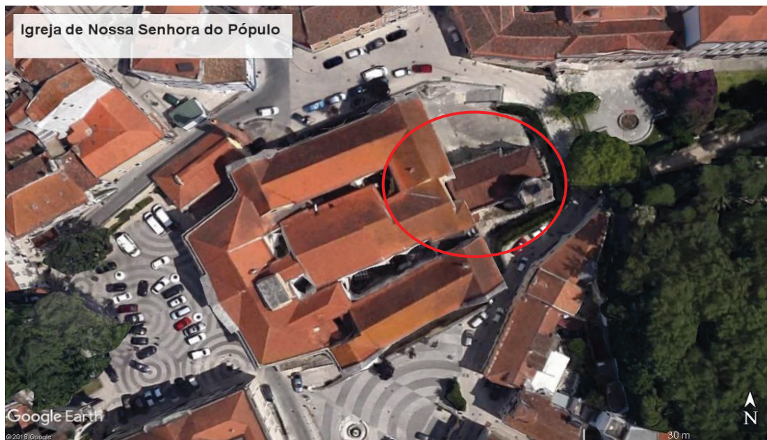
Figura 1. Localização da Igreja de Nossa Senhora do Pópulo em fotografia aérea. Fonte: (Google Earth), 2019.
