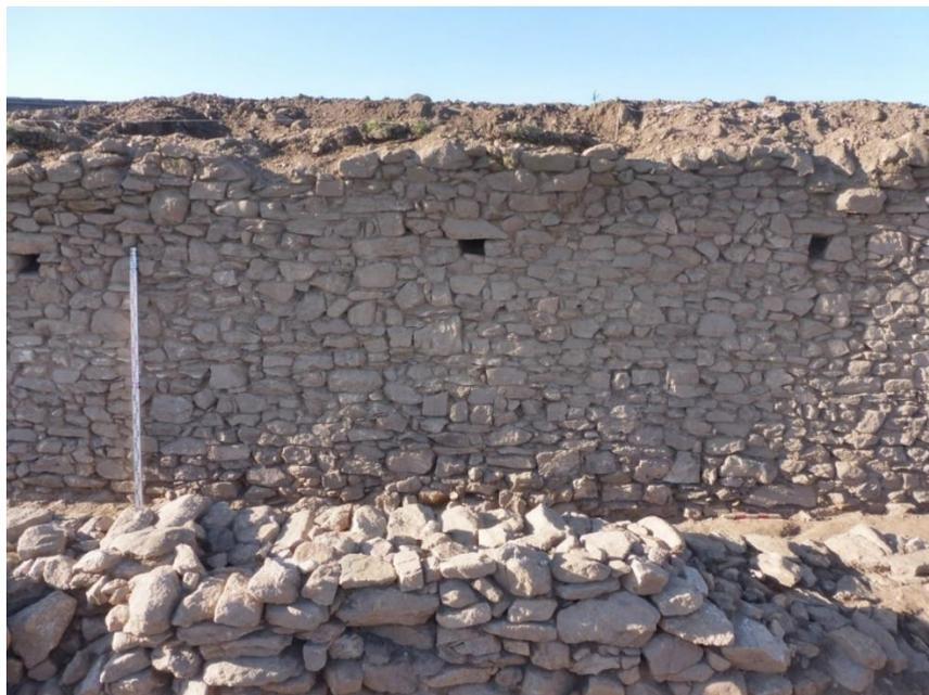
*Figura 8.* Pormenor do alçado e dos orifícios para disparo de armas de fogo da bancada de tiro. Fonte: Autores.
