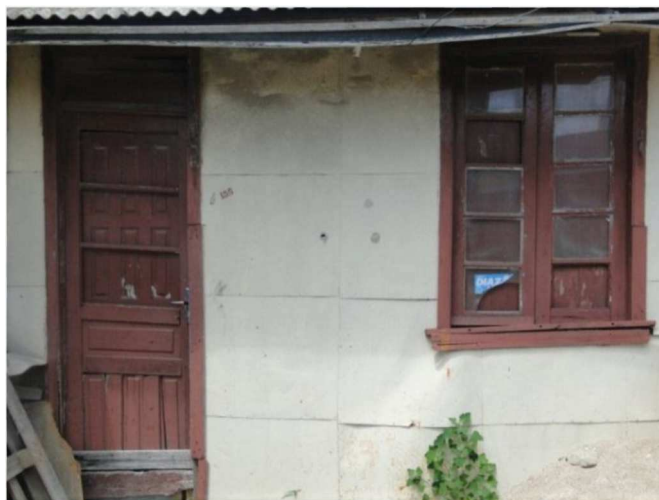
Figura 11. Fachada da Casa Verde 1. Fonte: Freddy Bager Jr.
