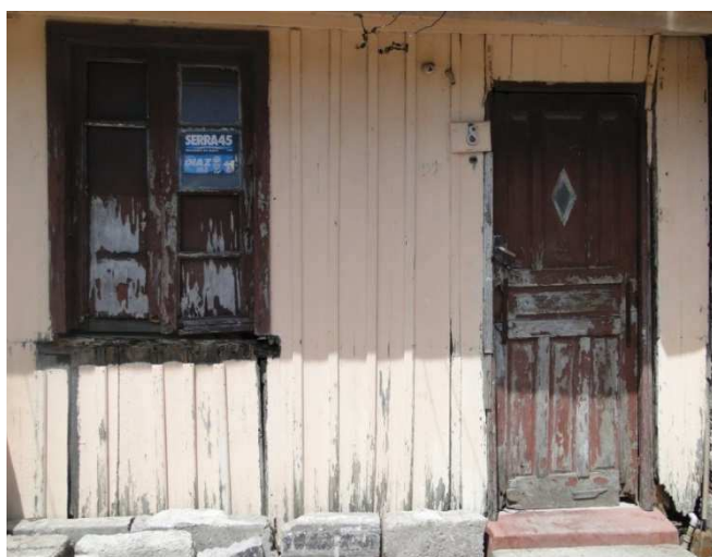
Figura 12. Fachada da casa verde 2. Fonte: Freddy Bager Jr.
