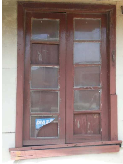
Figura 16. Janela da Casa Verde 1. Fonte: Freddy Bager Jr.
