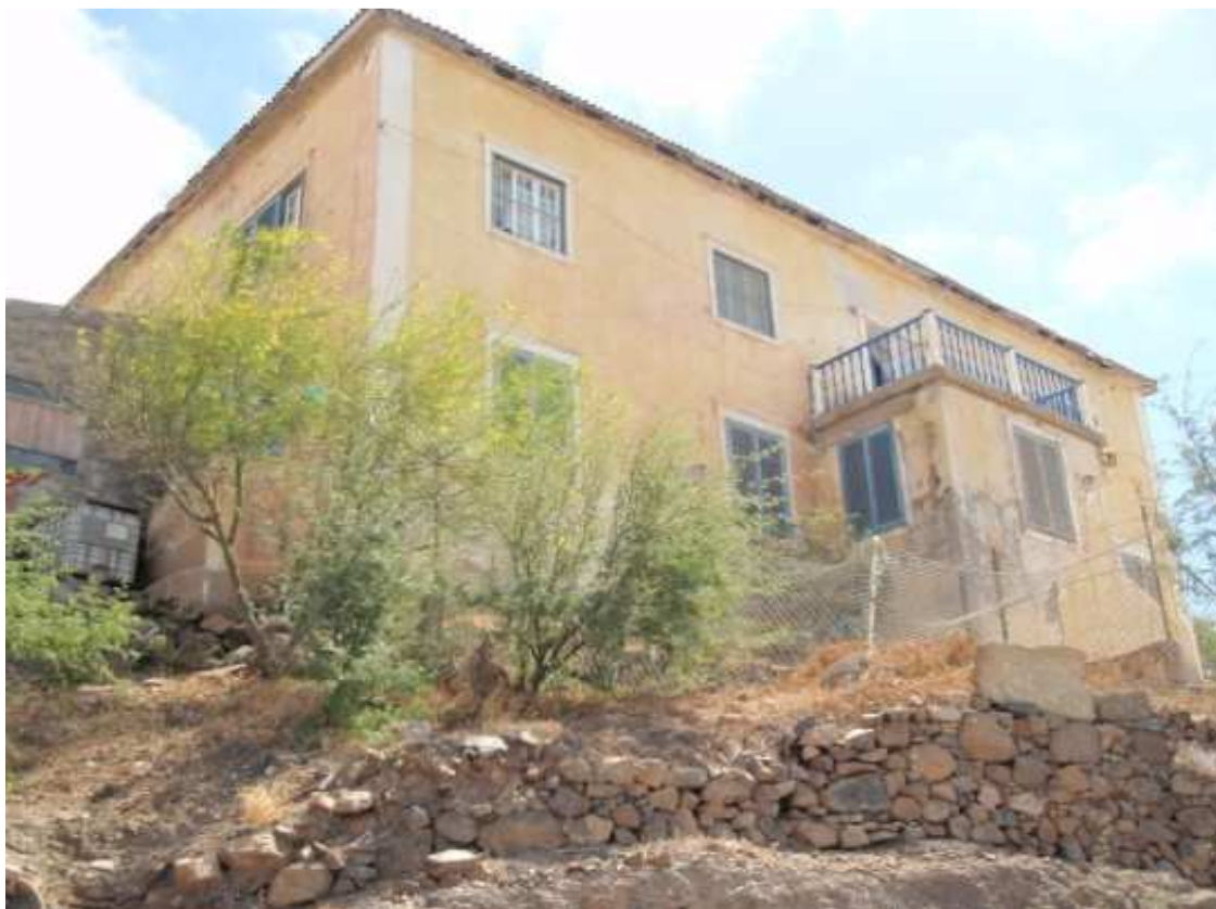
Figura 11. Antigo Consulado Inglês. Fonte: (MARQUES, 2012)
