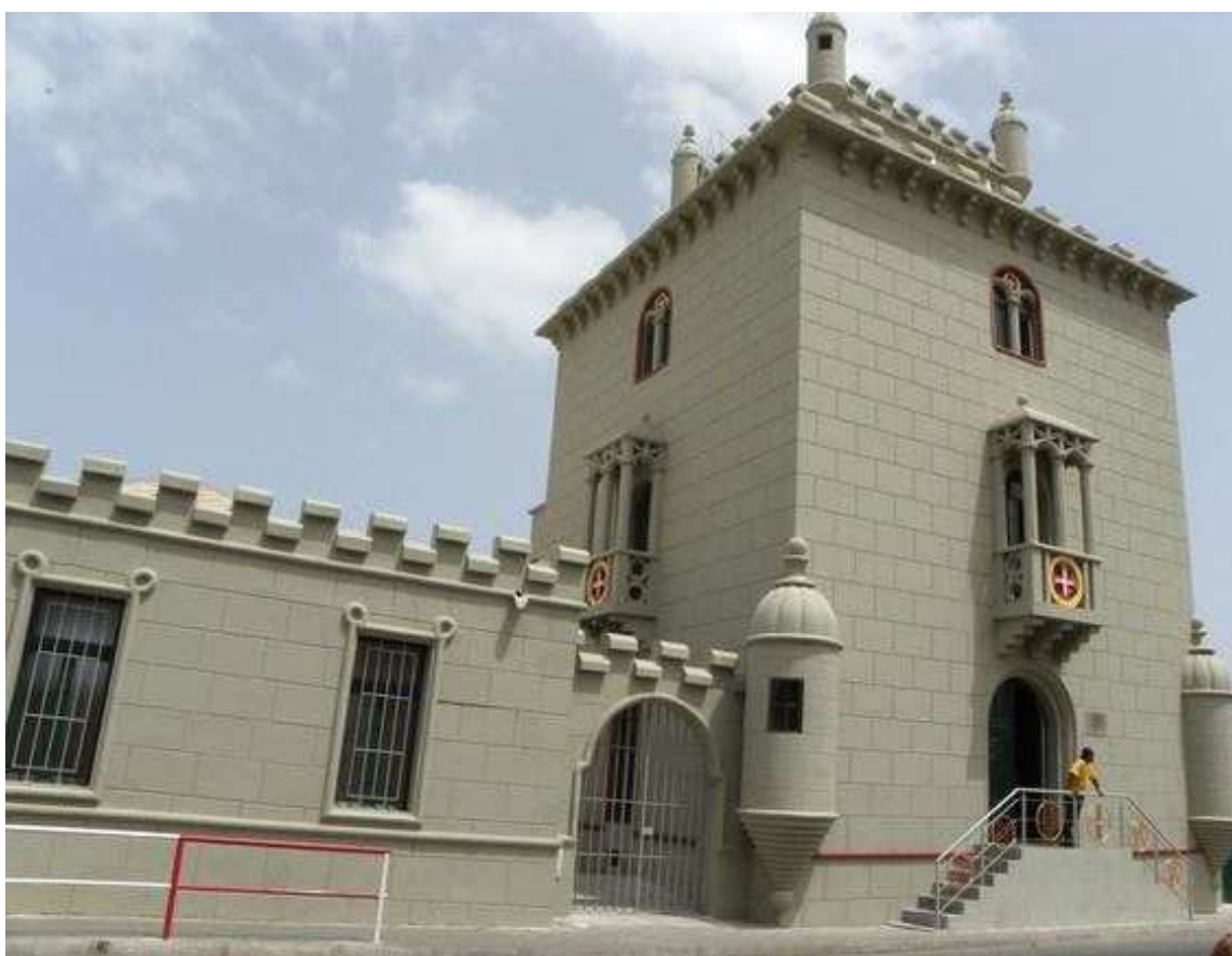
Figura 12. Torre de Belém, Mindelo, São Vicente. Fonte: (MARQUES, 2012)
