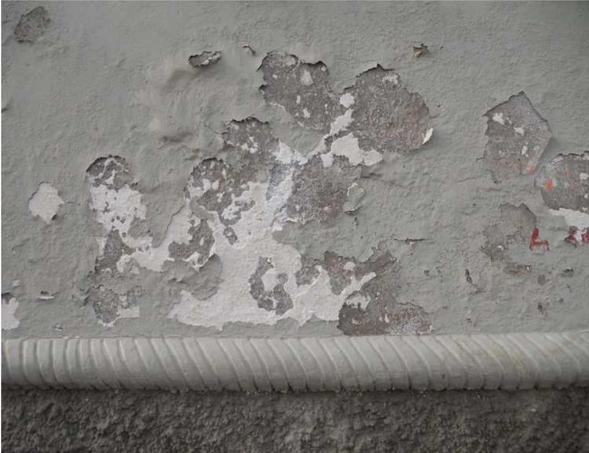
Figura 9. Degradação do revestimento após substituição do original por uma argamassa de cimento, Torre de Belém, Mindelo.
