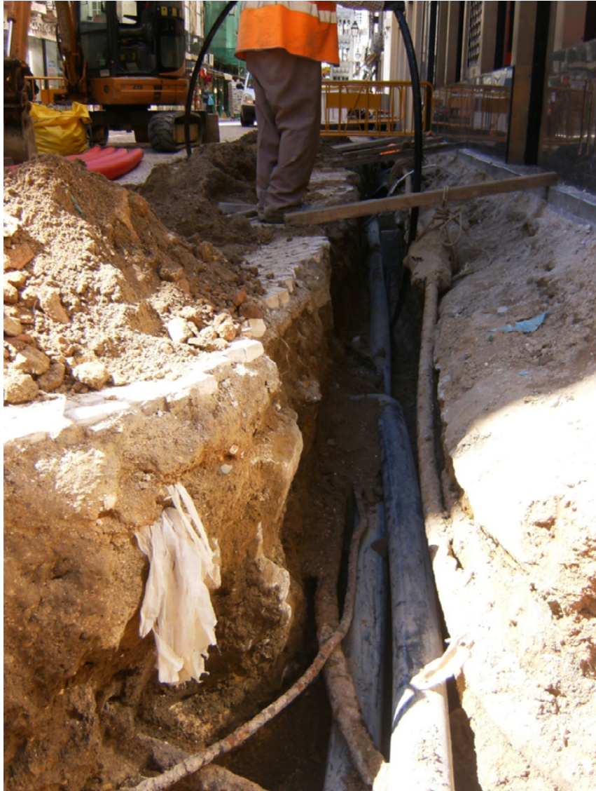
Figura 4. Pormenor de vala intervencionada na Rua de Santa Justa. Fonte: A Autora.
