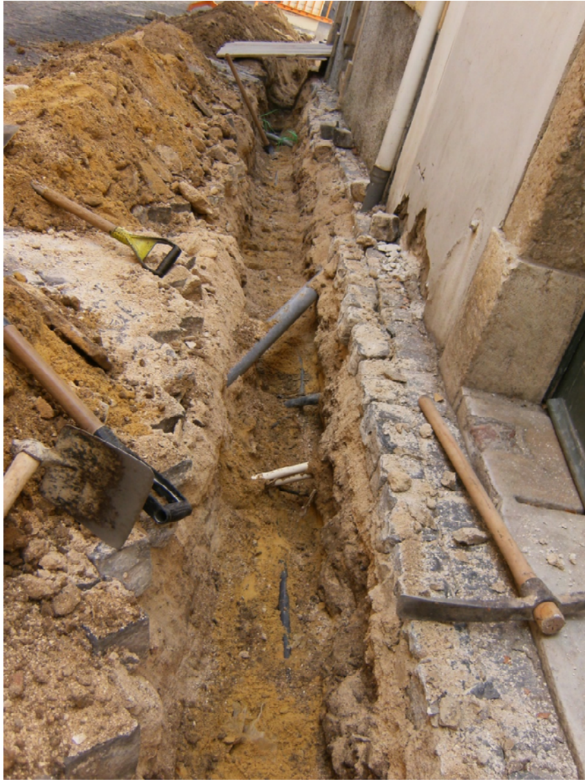
Figura 1. Pormenor de vala intervencionada na Rua Santa Cruz do Castelo. Fonte: A Autora.
