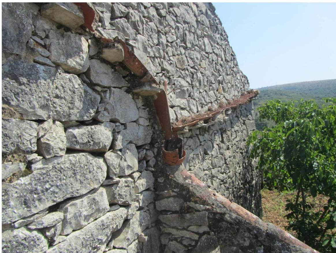
Figura 9. Pormenor das caleiras em telha invertida do sistema de recolha de águas pluviais do telhado, em Casais dos Vales (Alqueidão da Serra).
