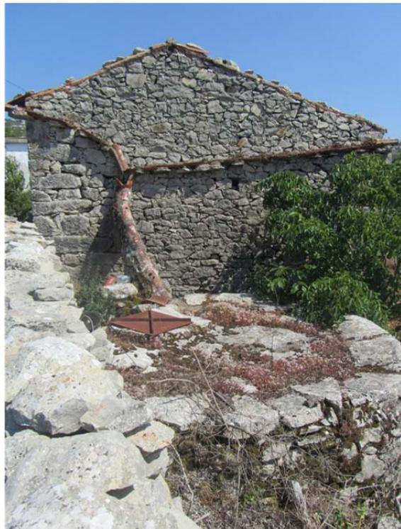
Figura 8. Sistema de recolha de águas pluviais do telhado, em Casais dos Vales (Alqueidão da Serra). **Fonte:** Autor, 2015.
