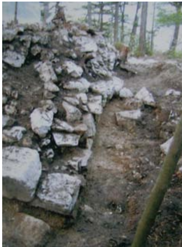
Figura 5. Particolare delle murature.
