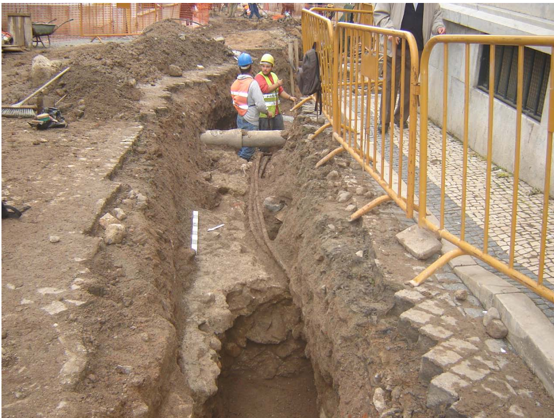
Figura 3. Troço de cloaca na Rua Conde da Boavista. Fonte: O Autor.
