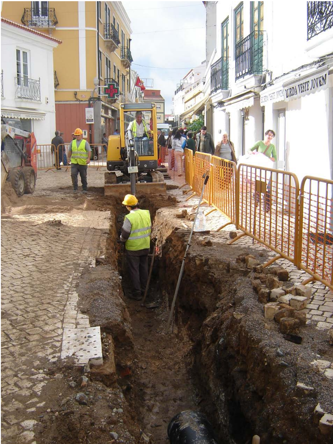
Figura 2. Abertura de valas na Rua de Mértola. Fonte: O Autor.
